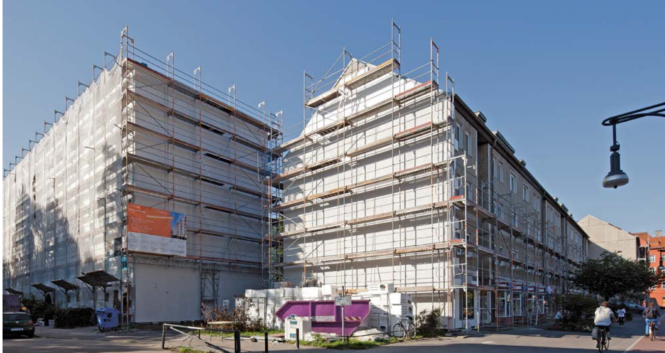
Modernisierungsarbeiten Breite Straße in Pankow
